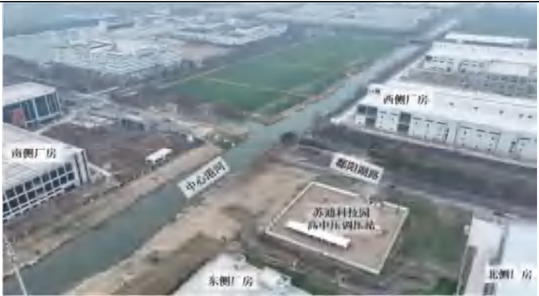
图 2-2 苏通调压站航拍图
