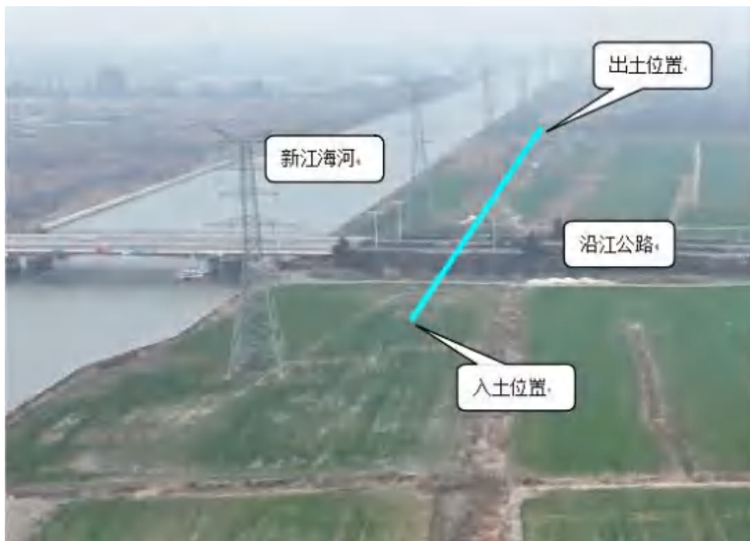
图 2-17 定向钻穿越沿江公路
