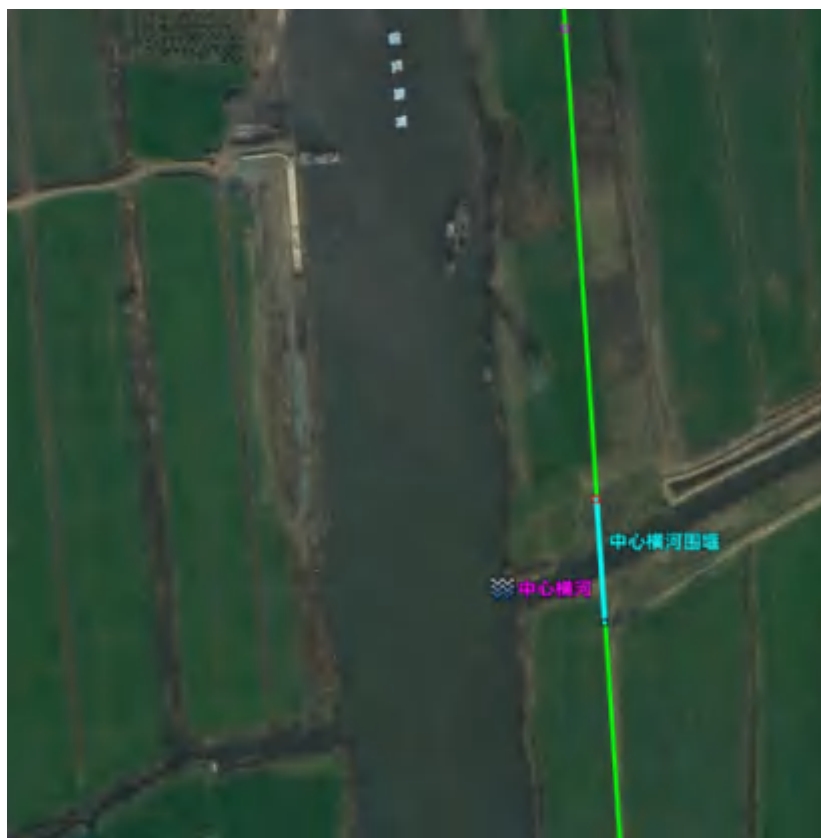
图 2-8 开挖方式穿越中心横河
