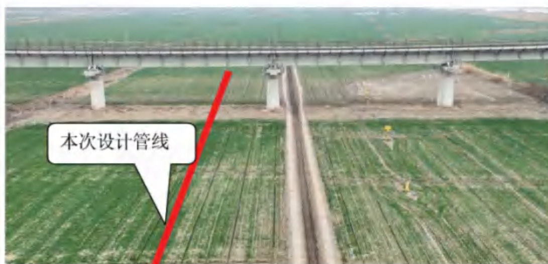
图 2-14 管道与通海铁路交叉
