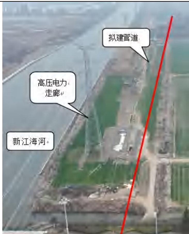
图 2-16 管道沿新江海河东岸敷设
